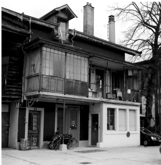
Maison à démolir vue par Jeanne Gerster
