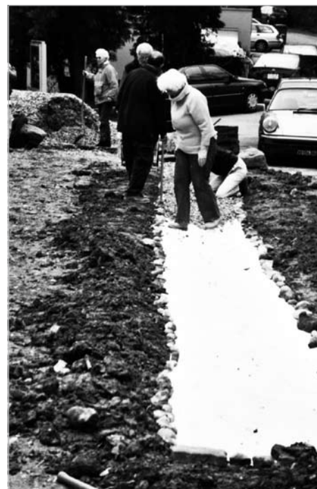
... avant d'y loger soigneusement un bidim (drap de protection) qui évitera aux copeaux de bois du revêtement de se mélanger à la terre. Merci à la Commune de Chigny qui a financé les copeaux.
