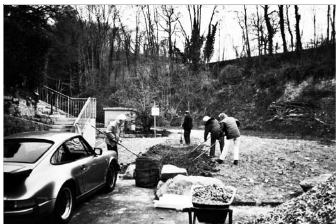
A la Morgette, il fallut creuser le «lit» du sentier...
