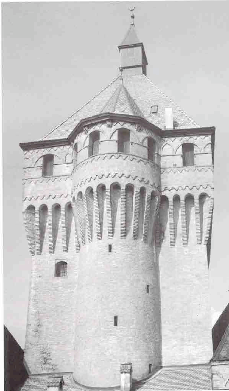
Fig. 29. Château de Vufflens. Le couronnement du donjon, avec ses crochets de «volets de siège» de part et d'autre des baies-crèneaux (photo Claude Bornand).
