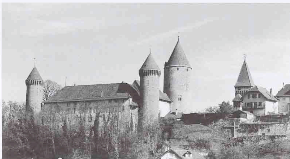
Fig. 56. Le château de Cheneau à Estavayer (Fribourg), vu du sud-ouest. Les trois tours en brique ont été ajoutées entre 1436 et 1441 par Girardin Barbieri, de Buronzo (Vercel), Dominique Trabucherus, de Chieri, et Jean de Cilavegna (Pavie) (photo Claude Bornand).
