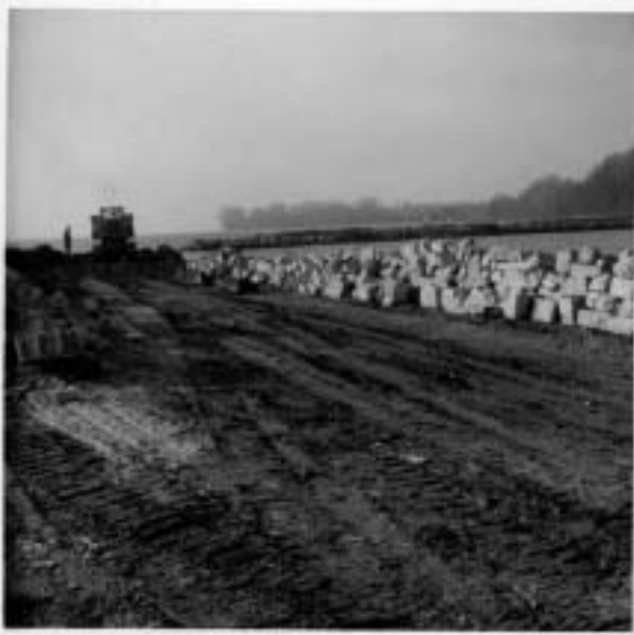
Construction de la digue est du Port du Petit-Bois
