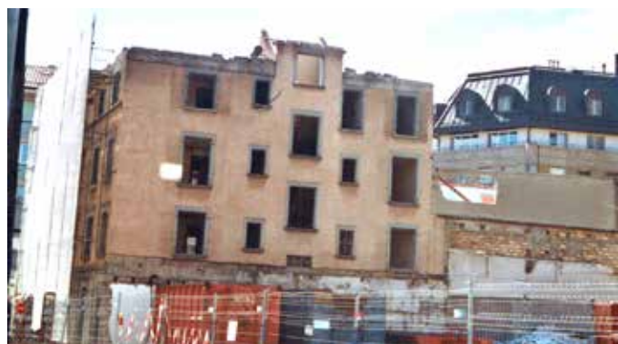
Démolition de l'immeuble Av. de l'Avenir/Av. Gare - 2005
