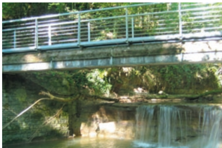
Le «pont-tuyau» en amont de la Morgette rénové et sécurisé par les services communaux de Morges.
