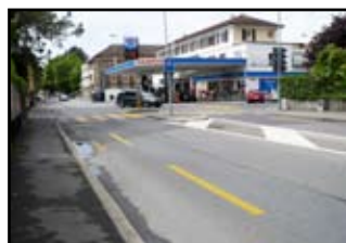
La requalification de la route du Lac est le chantier n°2 de Région Morges. Il se poursuivra à Morges
