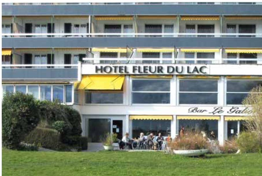
Dernier café avant la démolition
