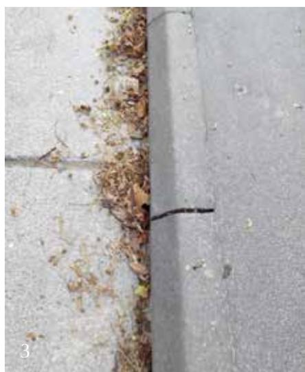
chute et glisse contre le trottoir. Les dégâts peuvent être aussi matériels pour les pneumatiques et jantes des cycles et des voitures qui touchent ces bordures. Pourquoi ne pas avoir fait une exécution telle que celle de la Longeraie où les bordures du giratoire et des trottoirs ne présentant pas cet angle tranchant (Photo 2).
